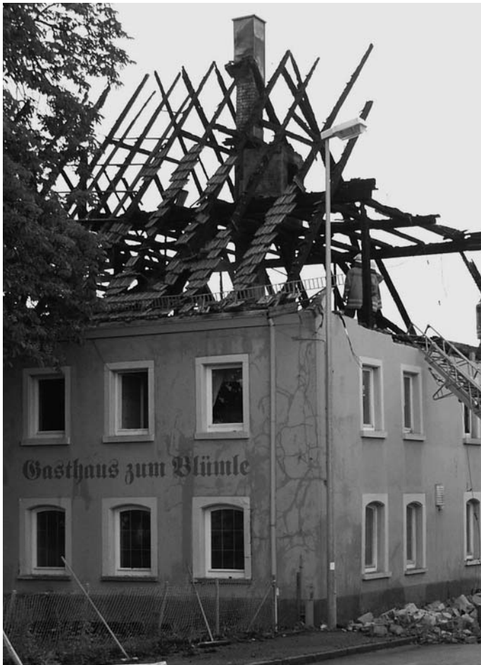
Der letzte Zeitzeuge zum Huttanz in Essingen, das „Gasthaus zum Blümle“, brannte am 3. Juni 2005 ab und wurde nicht mehr aufgebaut 6 . Heute steht dort ein Supermarkt.
